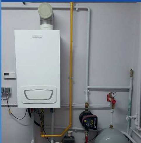
Budowa wewnętrznej instalacji gazu w świetlicy w Bytyniu.
