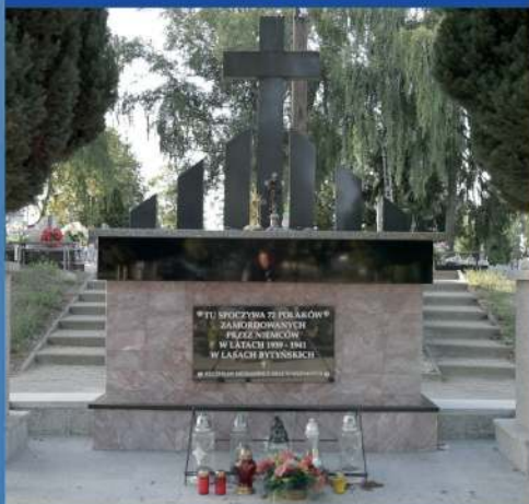
Przeprowadzenie prac remontowych zbiorowej mogiły ofiar terroru niemieckiego położonej na cmentarzu w Kaźmierzu.
